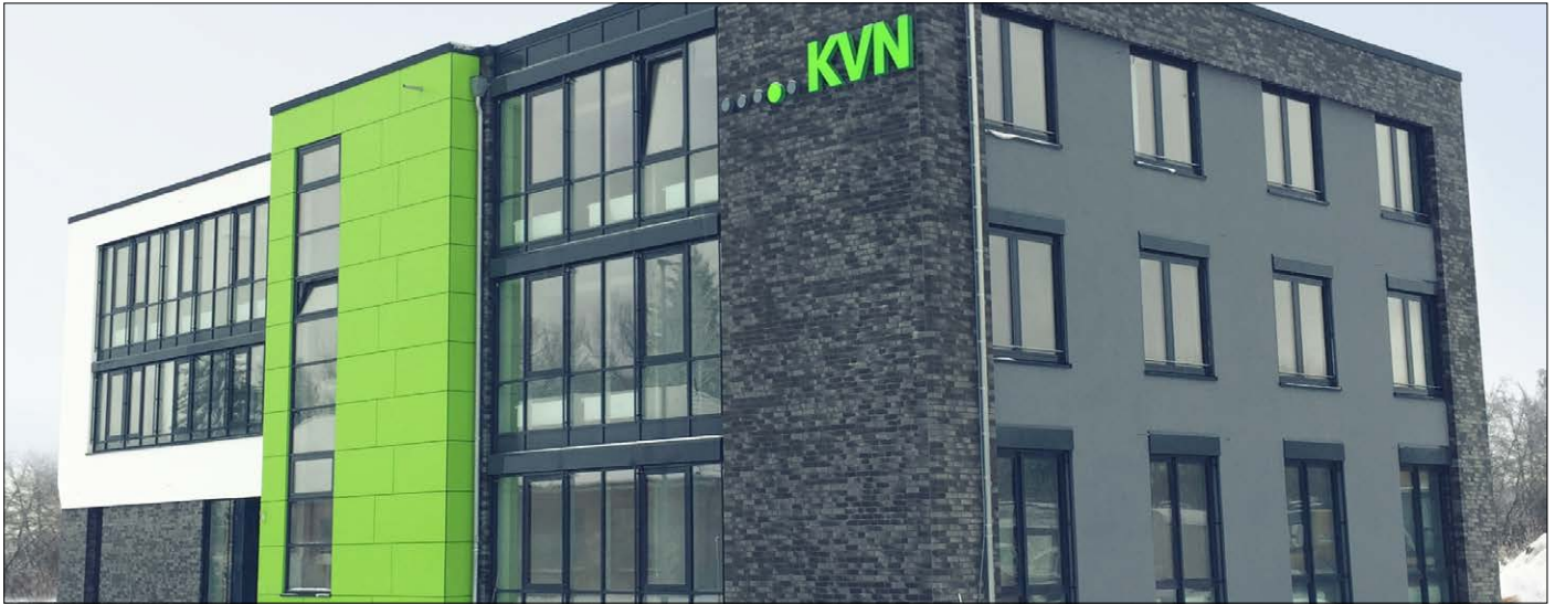
Startschuss für das Gebäude der Kassennärztlichen Vereinigung, das auffällt durch frisches Grün an der Wand. Foto: Strüning
