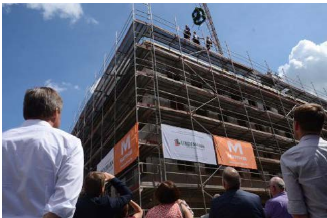
Seit Dienstag weht über dem Rohbau der Richtkranz. Foto: Strüning
