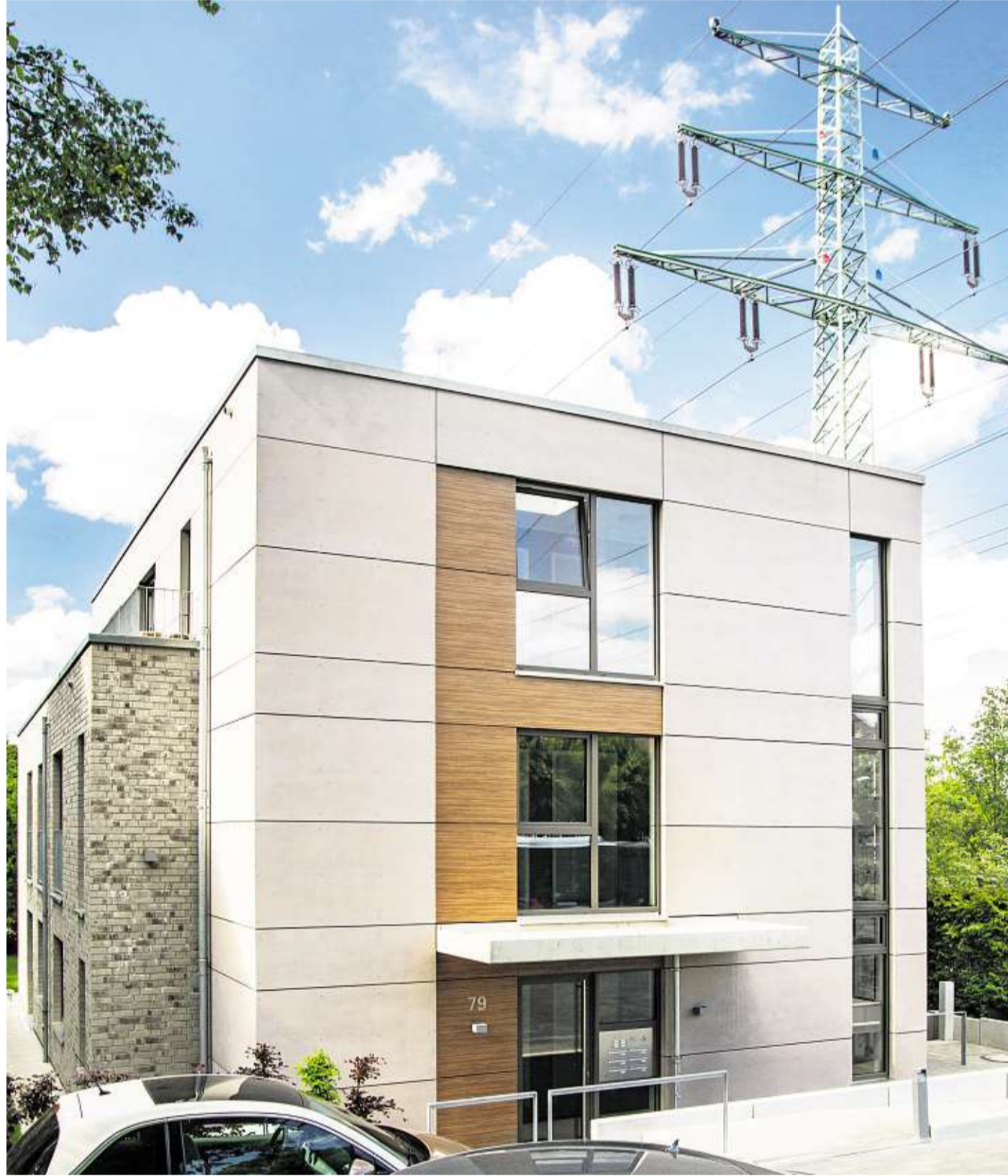
Wegen der Stromleitung wurde der Neubau in Marienthal um einen Meter tiefergelegt
