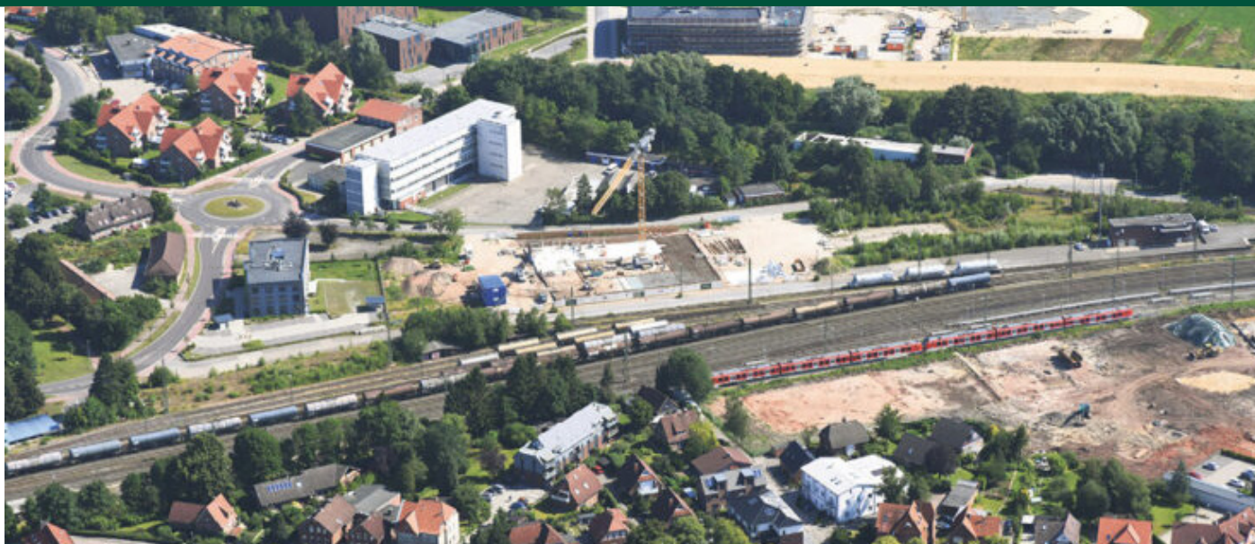
Direkt an der Bahn gelegen: Dieses Foto zeigt das Neue Behördenviertel in Stade und den Standort des neuen Jobcenters. Links steht das Gebäude der Kassenärztlichen Vereinigung, oben ist das bereits im Ausbau begriffene Jugendamt zu erkennen. || Foto: LINDEMANN-Gruppe
