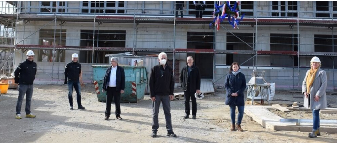
Bauleiter Christoph Lührs und Marcel Mügge, der den Richtspruch hielt, stehen während der kurzen Zeremonie am Richtkranz. Die offizielle Festgemeinde blieb am Boden. Foto: Strüning
