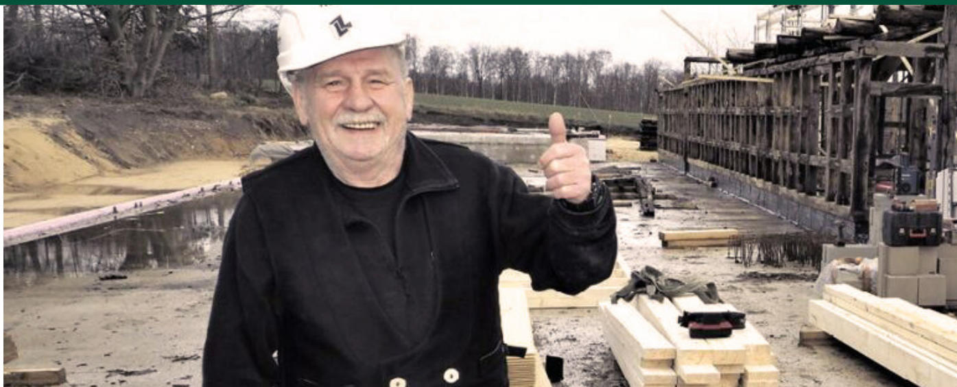
Heinz Mielczarek auf der Baustelle in Bendestorf. Der umtriebige Parchimer ist mittlerweile 70 und heilfroh, dass er als Fachmann weiterhin seinen Job als Polier machen darf. | Foto: Wolfgang Becker
