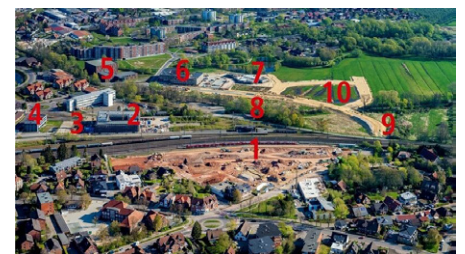
Zehn Bauprojekte auf einen Blick. Zwischen Altländer Viertel (oben) und Campe (unten) entstehen neue Quartiere. Luftfoto: Martin Elsen
