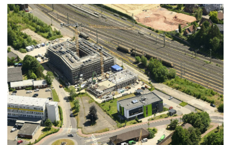
Der Neubau während der Bauphase aus der Vogelperspektive
