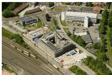
Der Neubau während der Bauphase aus der Vogelperspektive
