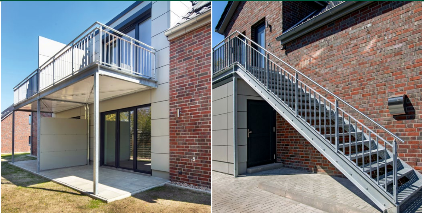
Bauvorhaben: Harburger Straße, Buxtehude
